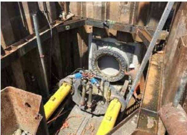
Rohrvortrieb in Startgrube
