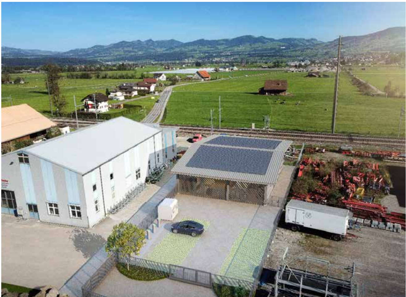
Die neue Sammelstelle bietet neben der Entsorgung und dem Recycling auch Raum für das Elektrizitätswerk. Die Räumlichkeiten des EW sind dabei baulich von der Sammelstelle getrennt.
