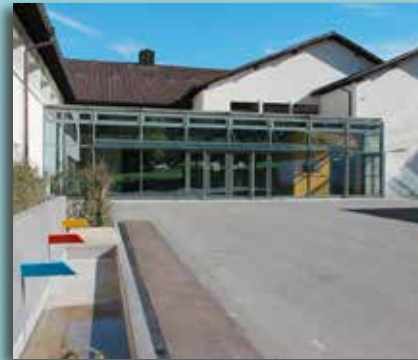
Mehrweckgebäude mit Foyer
