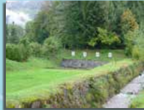
Sanierung Kugelfang Schützenhaus
